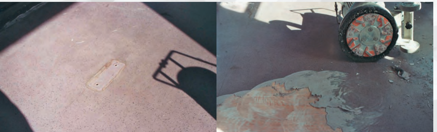
PKD-Frässcibe 250 NT mit Stützsegmenten: Entfernen eines 3 mm PVC-Belages von einem Holzboden (Wagonbau)
