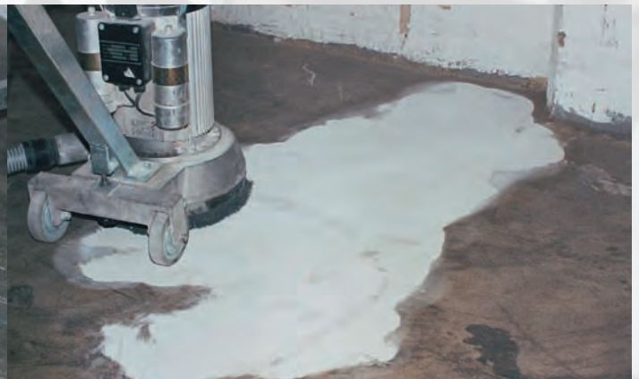
Diamantfrässcheibe 250 NT rot abrasiv: Anschleifen einer mechanisch hoch beanspruchten Epoxidharzbeschichtung
