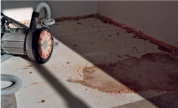
PKD-Frässcheibe 250 NT mit Stützsegmenten: Entfernen eines CV-Restbelages inkl. Kleber
