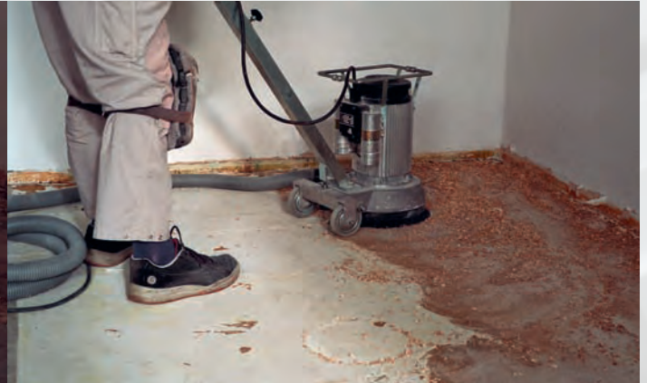
PKD-Frässcheibe 250 NT mit Stützsegmenten: Entfernen eines CV-Restbelages inkl. Kleber
