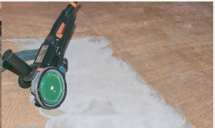
Auch PVC-Bodenbelagsrückstände oder Teppichbodenkleber lassen sich problemlos entfernen.
