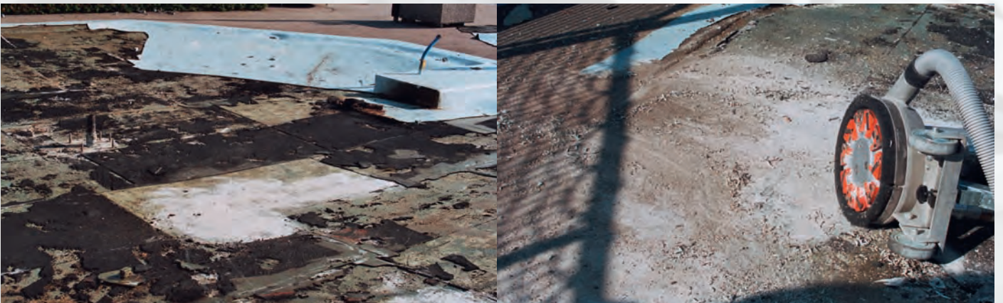
PKD-Frässcibe 250 NT mit Stützsegmenten: Entfernen von verklebter Schwimmbadfolie
