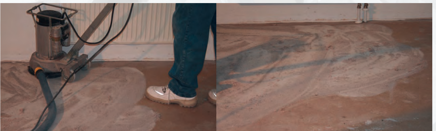
PKD-Schleifscheibe 250 NT 5 Pin: Untergrundschonender Abtrag von Teppichbodenkleber
