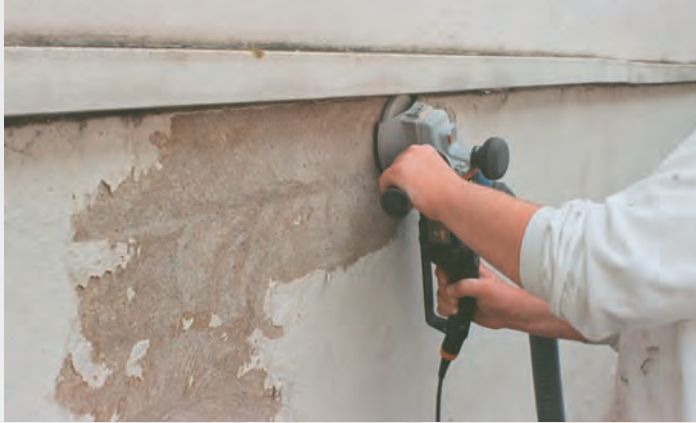
Altbeschichtungen randgenau entfernen.
