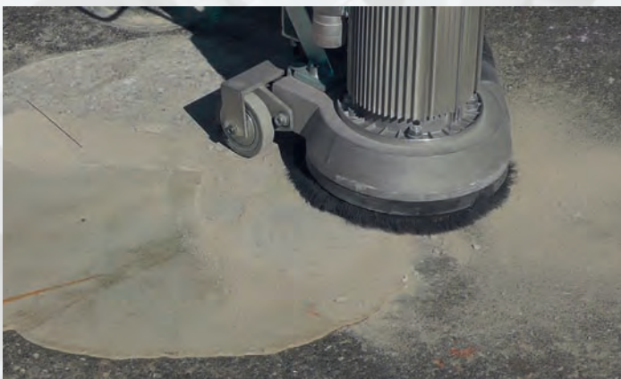
PKD Fünf-Segmente 250 NT: Abfräsen hochkunststoffvergüteter, faserarmer Spachtelmasse
