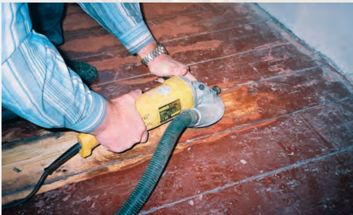
Selbst Bohnerwachs ist mit der Split 115 gewölbt kein Problem, die Split 115 plan würde zuschmieren.
