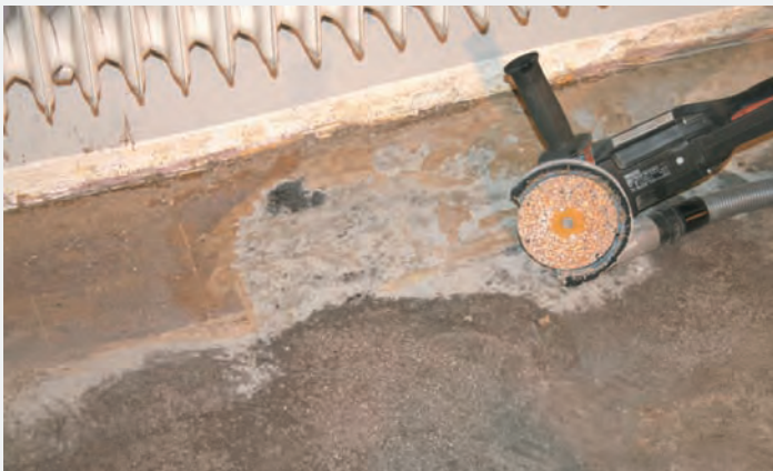
Auch PVC-Bodenbelagsrückstände oder Teppichbodenkleber lassen sich problemlos entfernen.
