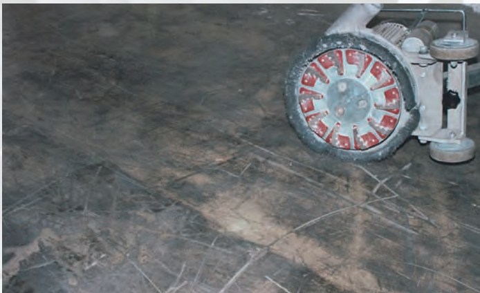
Diamantfrässcheibe 250 NT rot abrasiv: Anschleifen einer mechanisch hoch beanspruchten Epoxidharzbeschichtung
