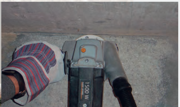
Auch PVC-Bodenbelagsrückstände oder Teppichbodenkleber lassen sich problemlos entfernen.
