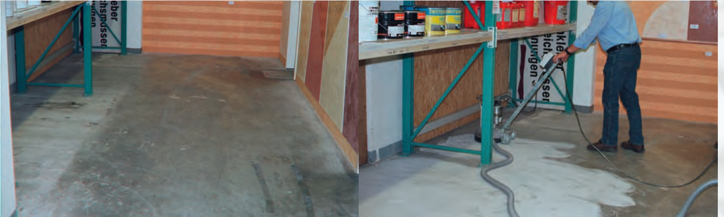
Diamantfrässcibe 250 NT für Beton: Abschleifen einer 1k-Altbeschichtung von einem Lagerboden
